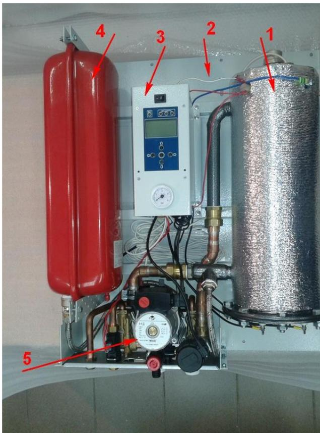
Рисунок 2. Общий вид водонагревателя «Premium»
